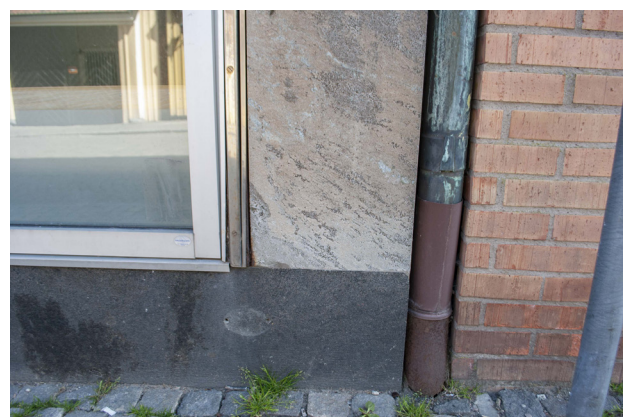
Materialvalen var viktiga, och allt är utfört med hög hantverksmässighet, notera exempelvis det infällda stup-röret i koppar och det fina mötet mellan gnejsen och marmorn i sockeln.
