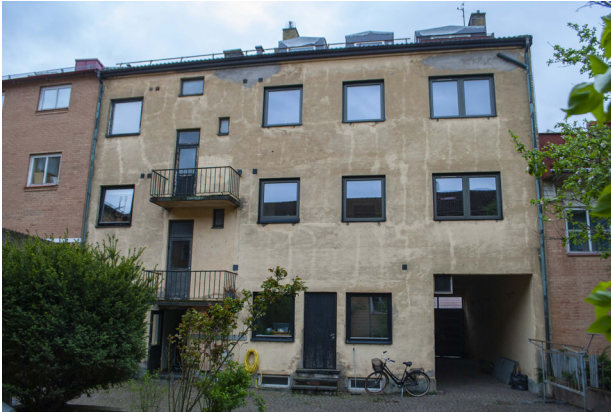
Gårdsfasaden är mycket välbevarad förutom att fönstren bytts ut.
